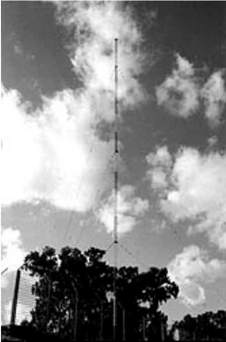
L'antenna alta 282 metri utilizzata per il trasmettitore ad Onde Lunghe a 189 kHz dell'impianto RAI di Caltanissetta (foto Andrea Borgnino, "the Italian HF Archive" http://www.mediasuk.org/archive/index.html ).
