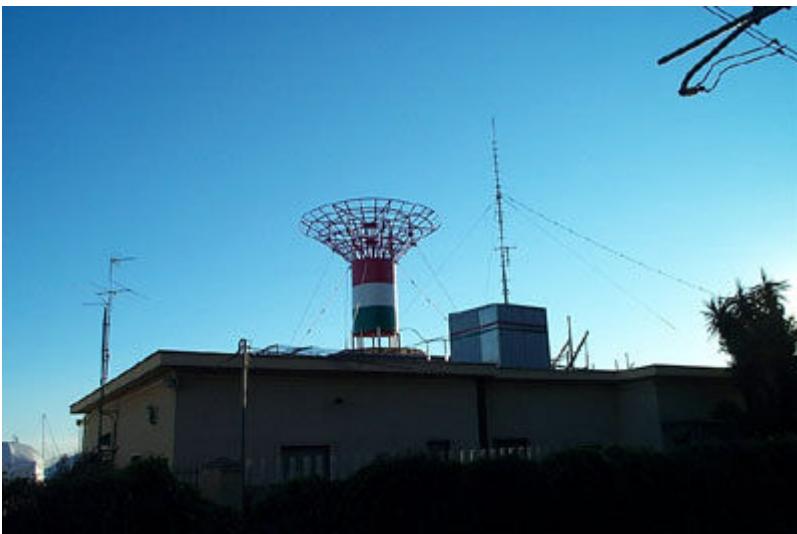
Qui si vede l'antenna sperimentale CFA (Cross Field Antenna) ad Onde Medie utilizzata dalla RAI nella postazione di Sanremo; il palo alla destra dell'antenna sostiene una filare obliqua a polarizzazione mista, che irradia Radio Uno su 1188 kHz (foto Andrea Borgnino, "the Italian HF Archive" http://www.mediasuk.org/archive/index.html ).
